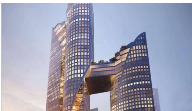
высотные здания с повышенной пожарной опасностью
