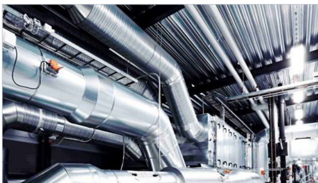
для монтажа трубопроводов
