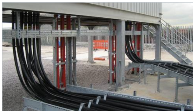
для монтажа энергоблоков и кабельных каналов
