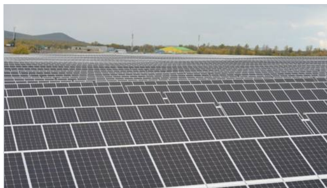
для монтажа солнечных батарей
